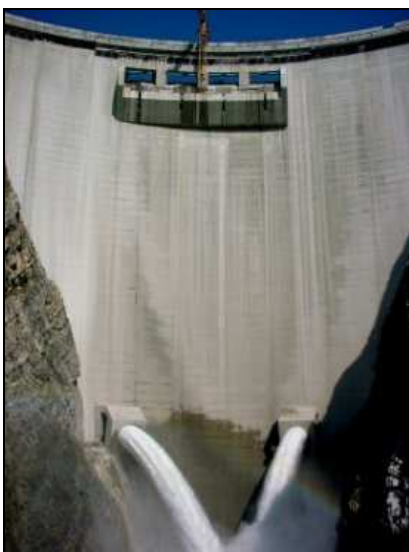
Le barrage hydroélectrique de Berke (Turquie)
